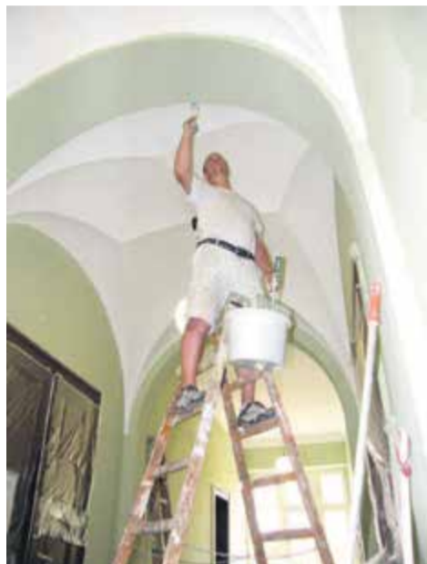
Handwerker sorgen für einen originalgetreuen Farbanstrich im Rathaus. Foto: Ziegner
