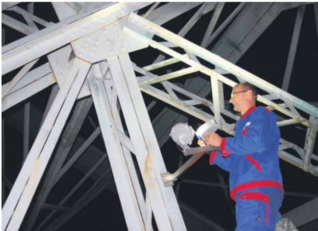
ACHTUNG, BELEUCHTUNGSPROBE: Elektroinstallateur Jens Wehner justierte am 12. Oktober die ersten LED-Scheinwerfer, um das Blaue Wunder ins richtige Licht zu setzen. Foto: Pohl
